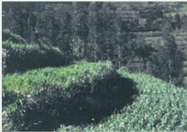
Hellingsstabilisatie door de techniek van terrasaanlag, Karago, Rwanda.
